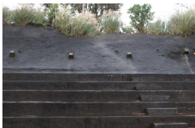
擋土牆設施注意安全
