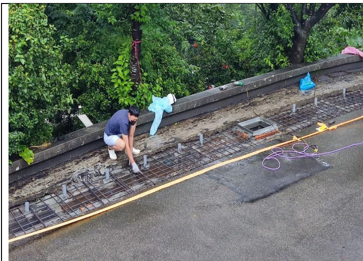
車道排水溝整修
